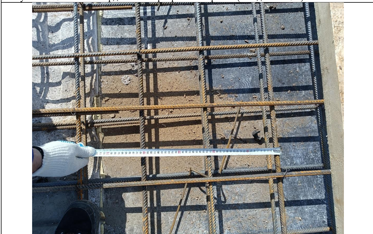
Рисунок А.18. Шаг армирования (200мм – дом 31 по генплану)
