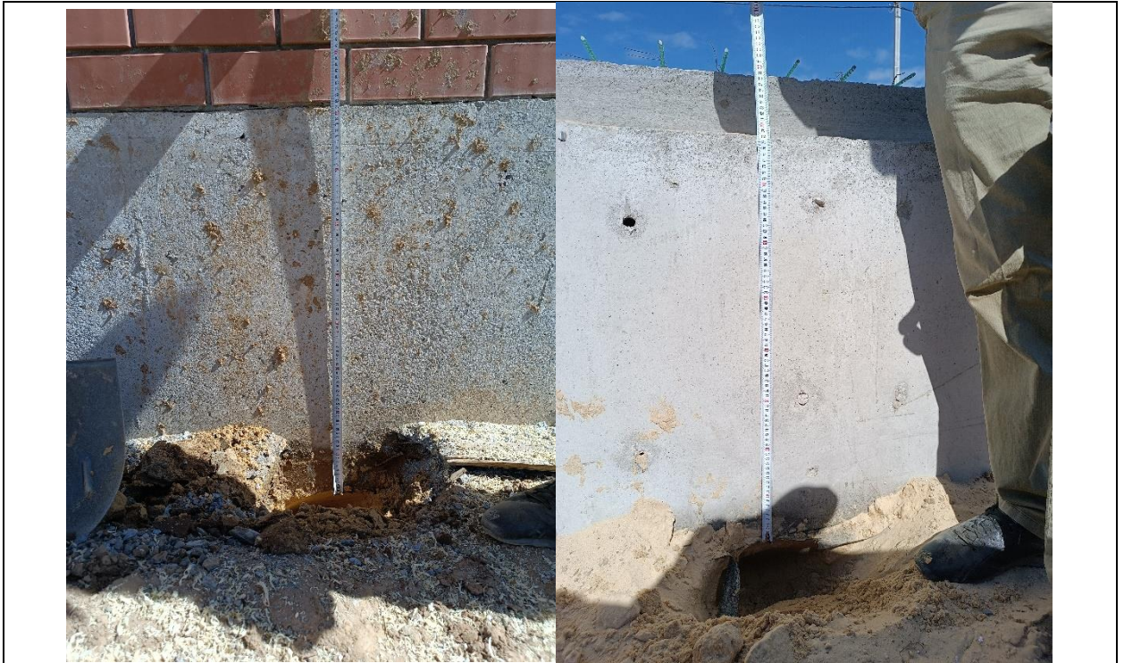
Рисунок А.1. Высота фундаментной ленты (800мм)
