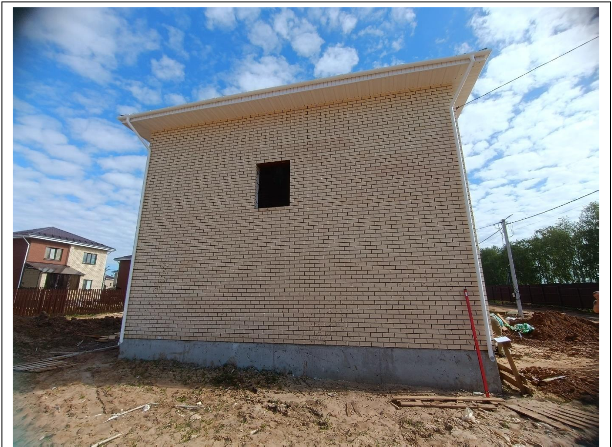
Рисунок 3. Вид слева на фасад жилого дома
