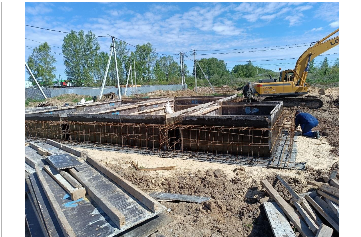
Рисунок А.3. Армирование фундаментной ленты
