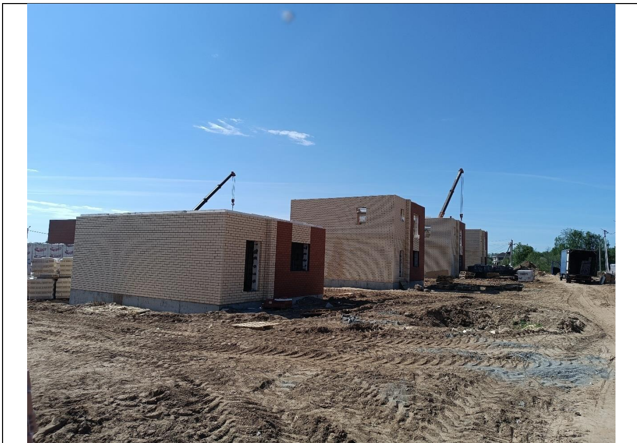
Рисунок 5. Общий вид на строящиеся дома
