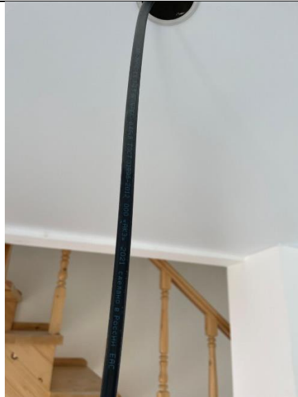
Рисунки 35. Кабель медный, ВВГ-нг (А)-LS 3x1,5 -0,66кВ, для проводки на световые приборы
