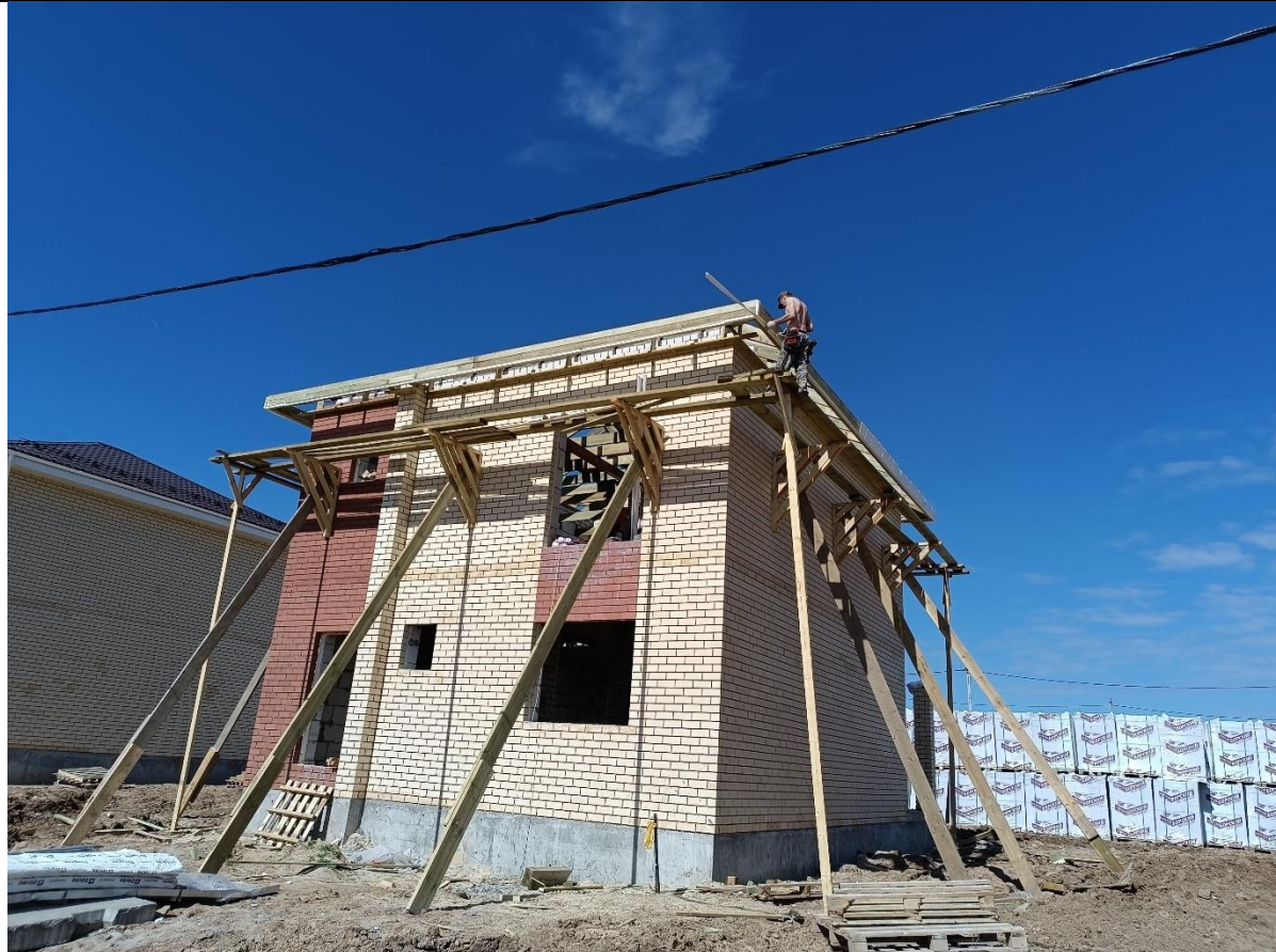
Рисунок А.8. Устройство стропильной кровли (монтаж)
