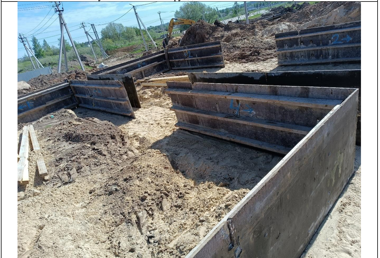
Рисунок А.2. Устройство опалубки под фундаментную ленту (выполнена песчаная подушка)
