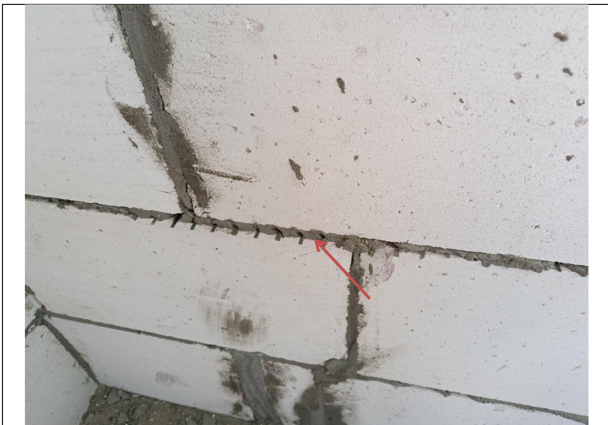
Рисунок А.15. Армирование кладки из газосиликатных блоков
