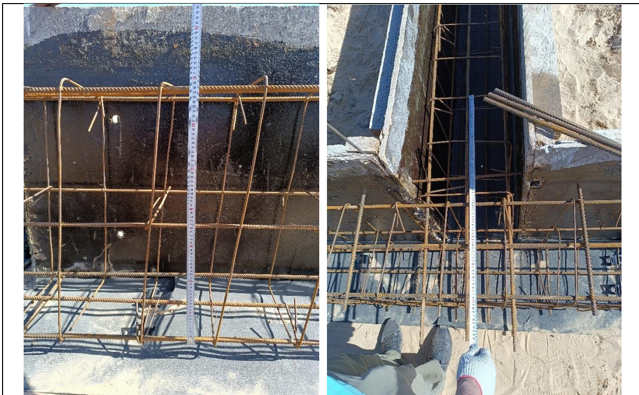
Рисунок А.7. Арматурный каркас фундаментной ленты
