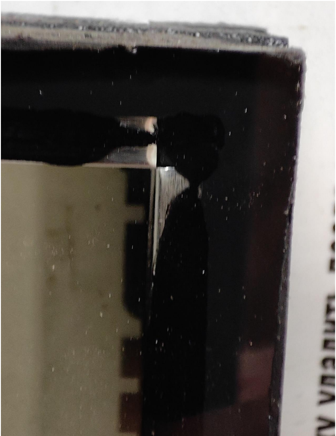
Рисунок 12 – Дефект в стеклопакете блока № 1
