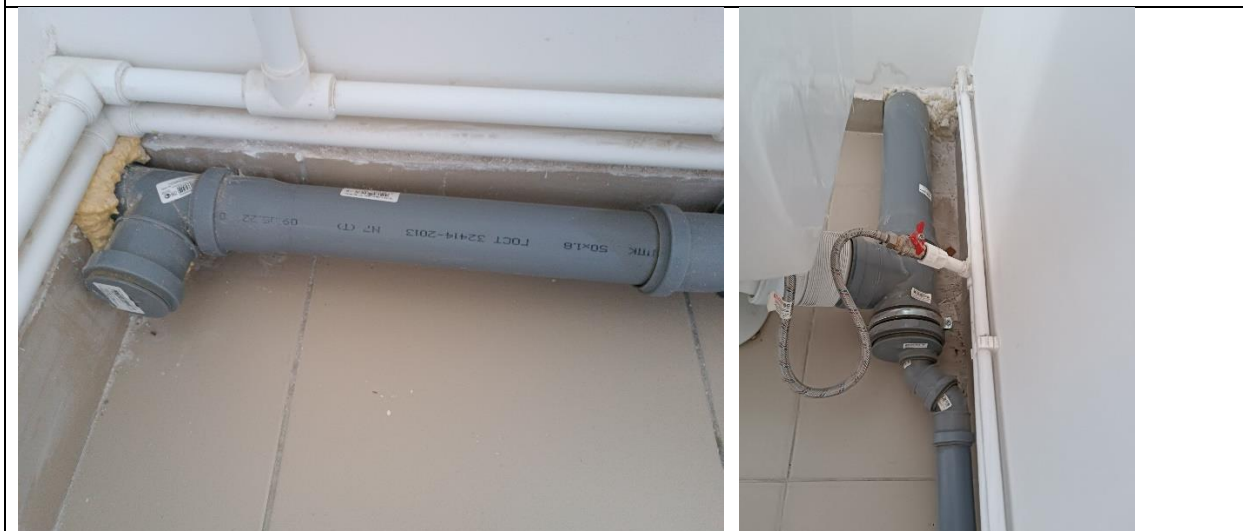
Рисунки 23-24. Канализационные трубы «Политек» полипропиленовые Ø 50 и Ø 110
