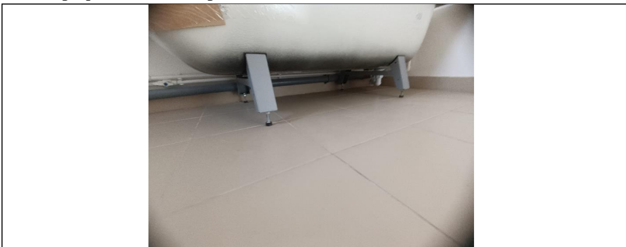
Рисунок 14. Напольное покрытие из керамической плитки, ванная комната
