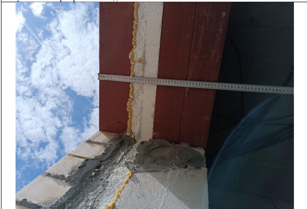
Рисунок А.16. Проем оконный (перемычка)
