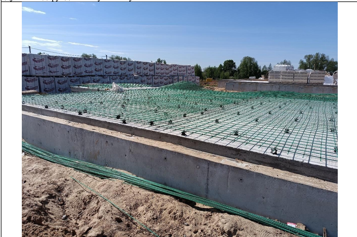
Рисунок А.6. Плита пола первого этажа (заготовка арматурной сетки под армирование пола соседнего дома)
