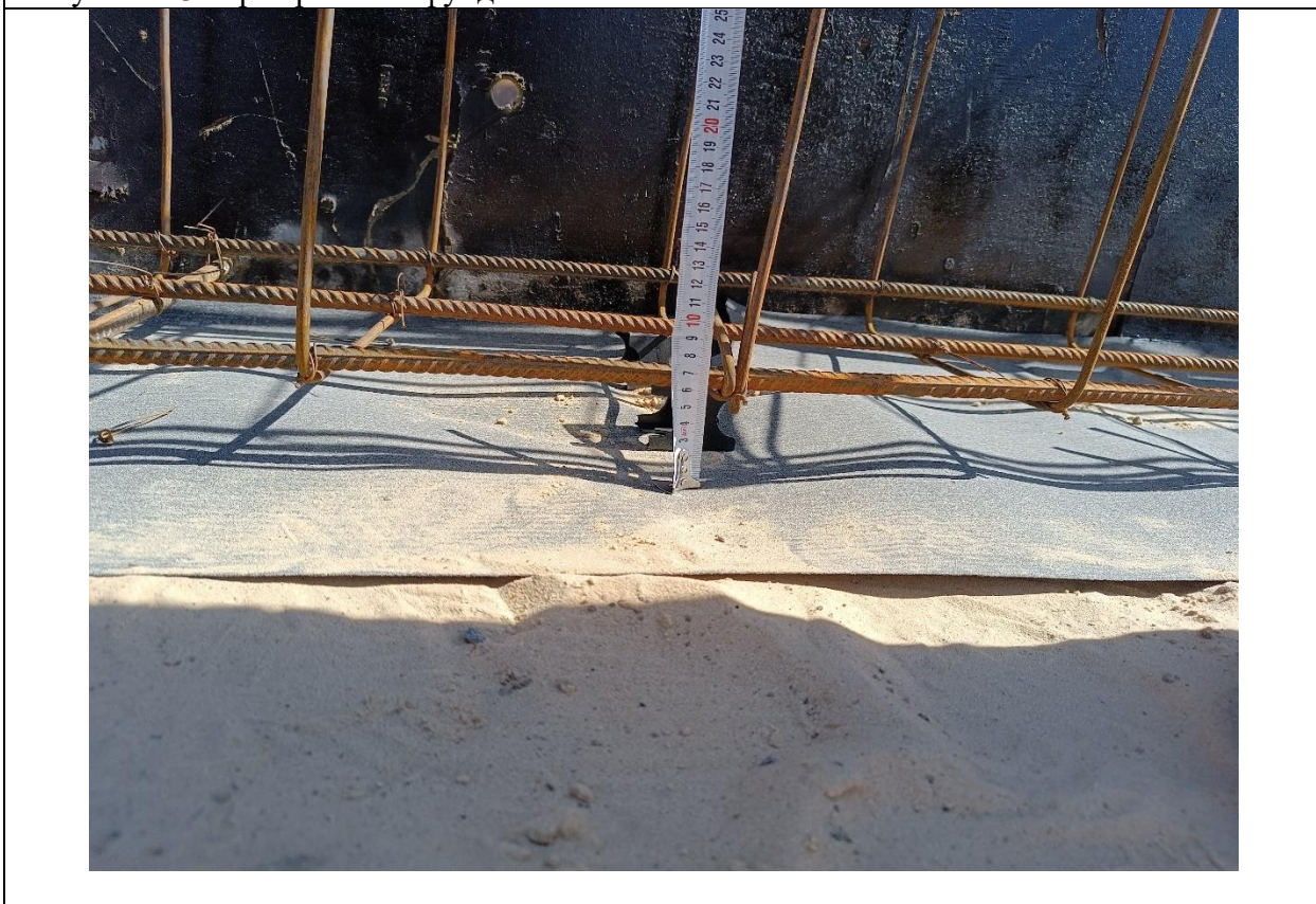
Рисунок А.4. Защитный слой (армирование фундамента)
