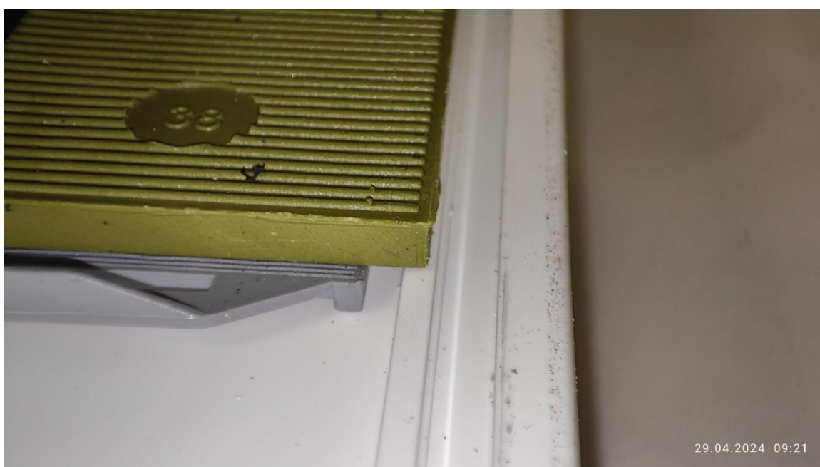
Рисунок 9 – Подкладка под стеклопакет в блоке № 1
