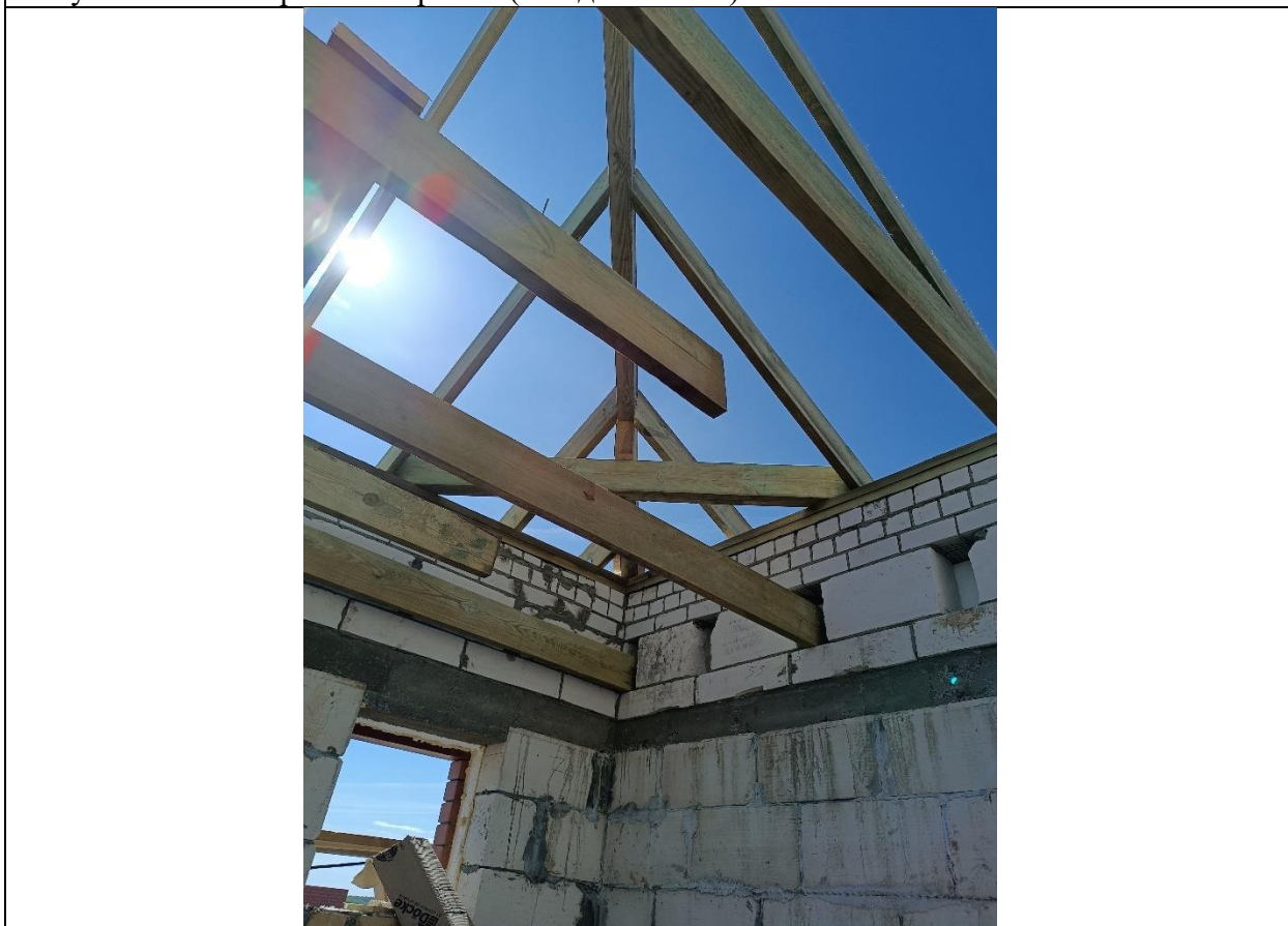
Рисунок А.12. Устройство кровли (тип дома 137А)
