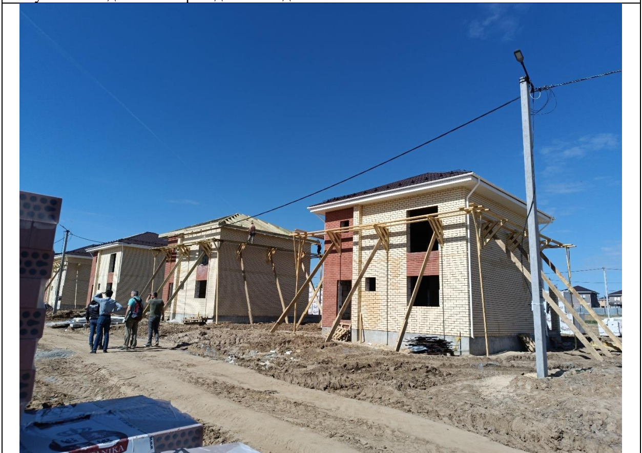
Рисунок 4. Общий вид на строящиеся дома
