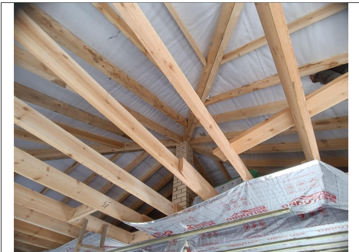
Рисунок А.17. Монтаж чердачного перекрытия и кровля (тип дома 148А)
