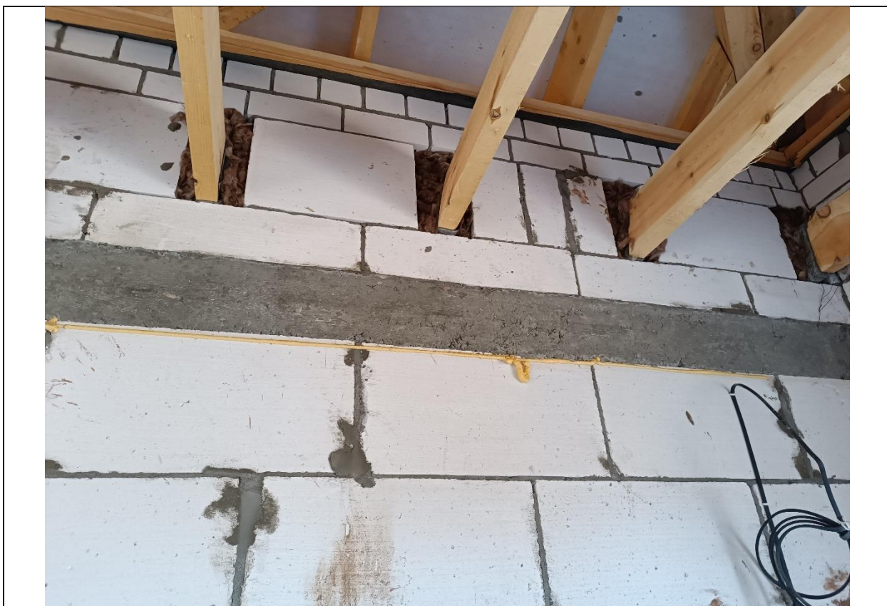
Рисунок А.19. Опора балок чердачного перекрытия
